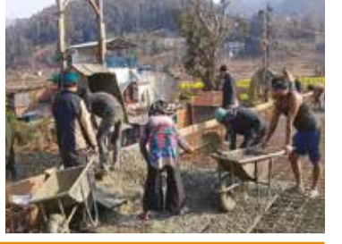
तनहुँको भानु नगरपालिका-६ र ७ जोड्ने गरी चुँदीखोला निर्माण हुँदै गरेको पुलमा कार्यरत मजदुर। वि.सं ०७५ वैशाख २८ गते निर्माण भइसक्नुपर्ने पुल ठेकेदारको लापरवाहीले समयमै सम्पन्न हुन नसकेपछि स्थानीयवासीको दबाबमा पुलको ढलान आइतबारदेखि सुरु गरिएको हो
